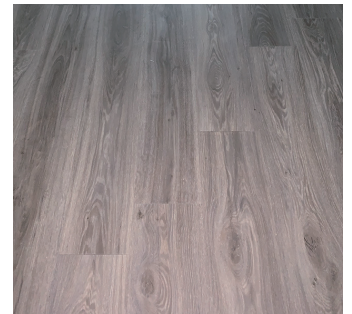
《フロアタイル施工完了》
