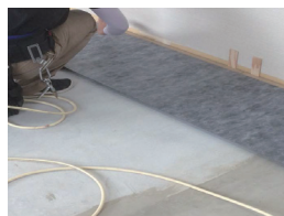
② 防音材の敷き込み 壁面より3～5mm隙間を取る
