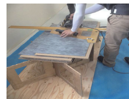
④ 納め代部分のカット 丸ノコにて切断
