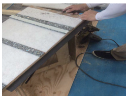
⑤ ウレタン緩衝脚の取付 吸音材を剥がす
