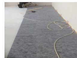
⑧ 施工 レンガ張り
