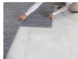
⑦ 施工 マットとマットの端部を突き当てる
