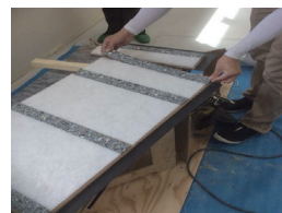
⑥ ウレタン緩衝脚の取付 補充用ウレタン緩衝脚取付
