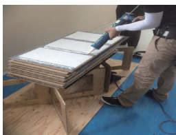
① ウレタン緩衝脚に接着材塗布 1液湿気硬化型ウレタン系接着材
